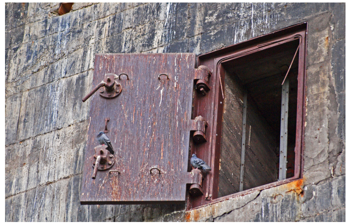
Offene Bunkertür | Bild: Uwe Duwald, pixelio.de
